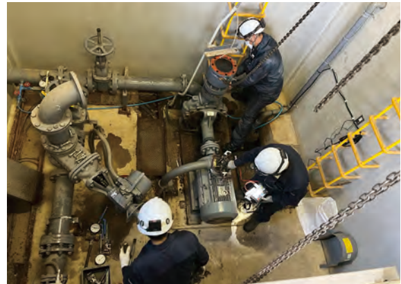
加圧機場ポンプ設備更新工事
