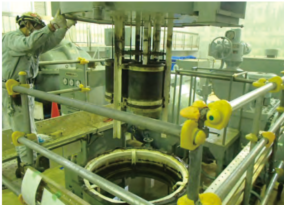
返田機場液体抵抗器整備工事
