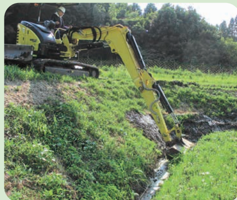
排水路浚渫作業
