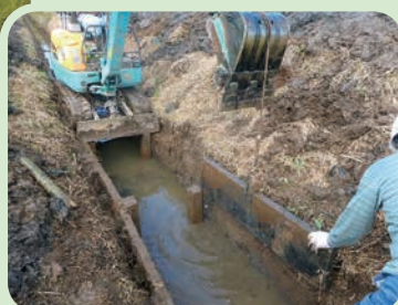
倒伏柵渠板の補修
