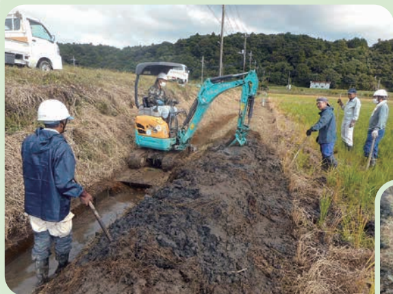
排水路泥上げ作業
