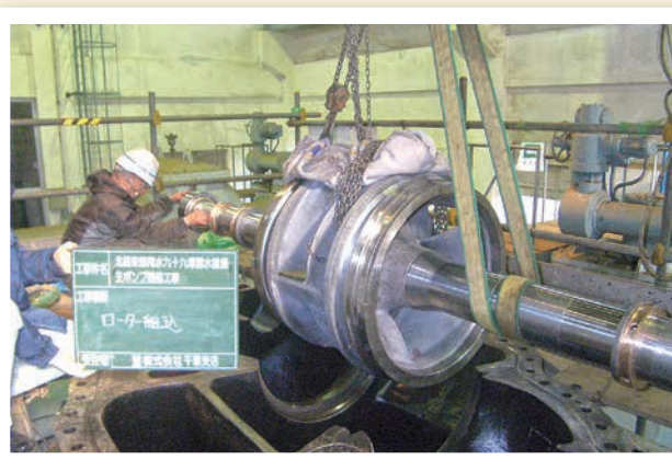
九十九塚揚水機場ポンプ整備工事
