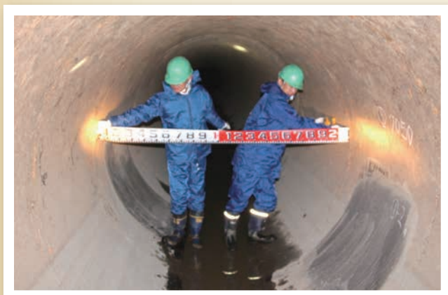
本管（管径2,100mm）管内調査
