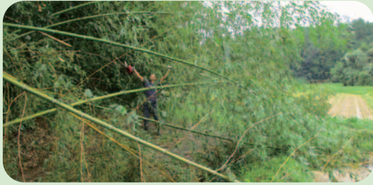
農道に傾倒した竹撤去
