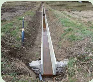
排水路補修後
