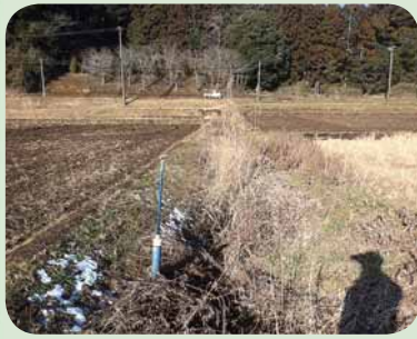
排水路補修前
